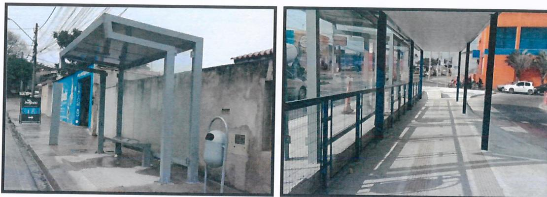
Na região do Jardim Ipiranga, os esforços estão concentrados na construção do terminal, que segue bem avançada. A cobertura, o assentamento de guias, a execução de calçadas e a concretagem da plataforma já foram concluídas.
